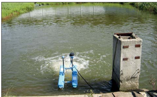
Obr. 10 – Instalace aerátoru na schody do sádky (omezení víření dna) k zabezpečení dostatku kyslíku ve vodě při omezeném přítoku vody. V tomto případě se jedná o sádkování ryb z letních odchyťů na plně vodě. Přítok do sádky je omezen z důvodu nízké teploty přítokové vody ve srovnání s teplotou vody v rybníce (foto J. Regenda)
