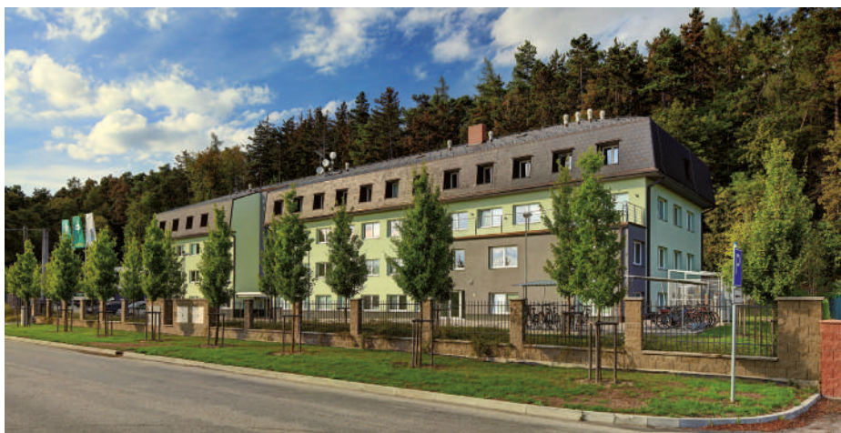
Rekonstruovaná hlavní budova FROV JU ve Vodňanech.
