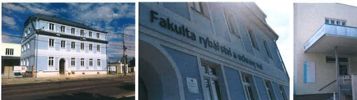
Obr. 2: Objekt FROV JU v Husově ulici (Modernizace FROV JU)
