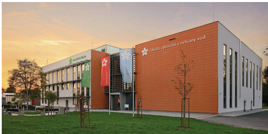
Novostavba FROV JU a ZF JU v ulici na Sádkách v Českých Budějovicích.
