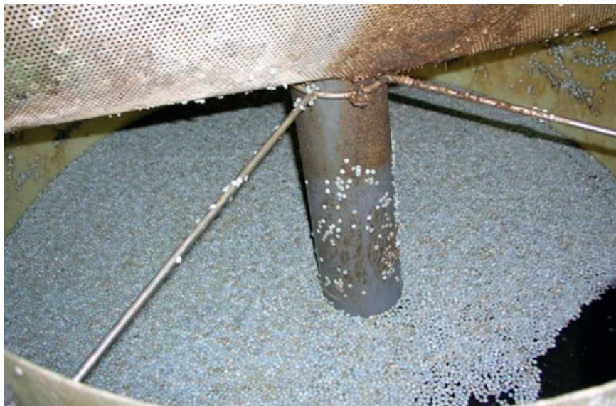
Obr. 18. Biologický fluidní filtr (filtrační náplň). Foto J. Kouřil.
