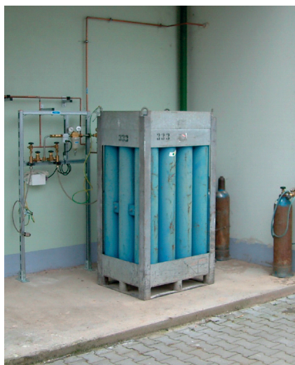
Obr. 26. Svazek tlakových nádob na kyslík pro zásobování experimentálního recirkulačního systému. Foto P. Kozdák.
