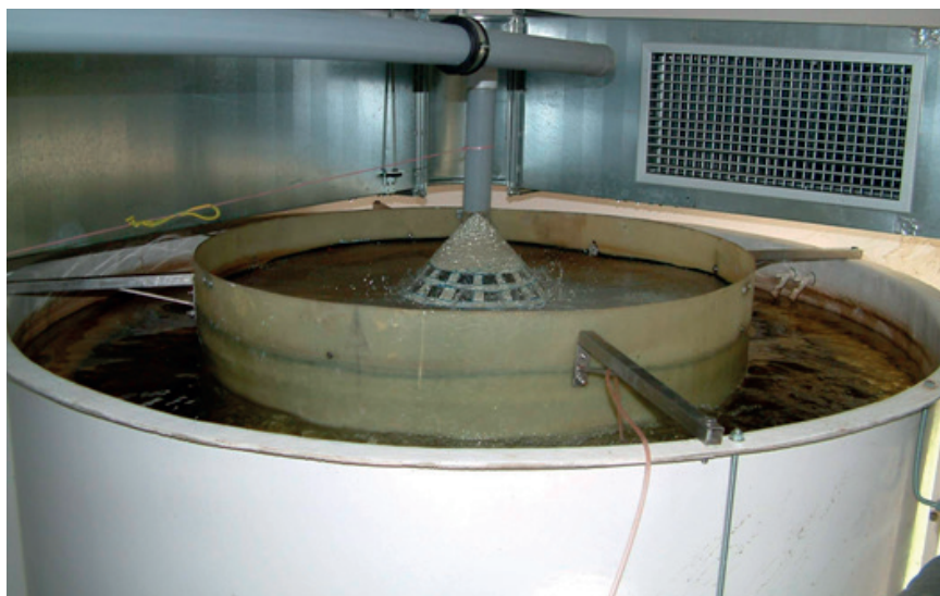
Obr. 17. Přítok vody do biologického fluidního filtru (ve vnitřním válci je umístěna filtrační náplň). Foto P.Kozák.
