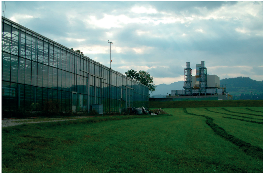
Obr. 21. Skleníků (Tropenhaus) s intenzivním chovem tilapie nilské využívající k ohřevu teplo z čerpací stanice dálkového plynovodu (Švýcarsko). Foto J. Kouřil.
