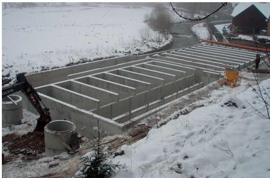
Obr. 33. Recirkulační systém pro chov lososovitých ryb dánského typu ve výstavbě (v pravé zadní části nádrže pro chov ryb, v levé přední části dvě části biologických filtrů, zcela vlevo dvě jímky, jedna pro jímání vody z pramene a průsakové vody na doplňování systému, druhá pro koncentrování sedimentovaných nerozpuštěných látek). Foto J. Kouřil.
