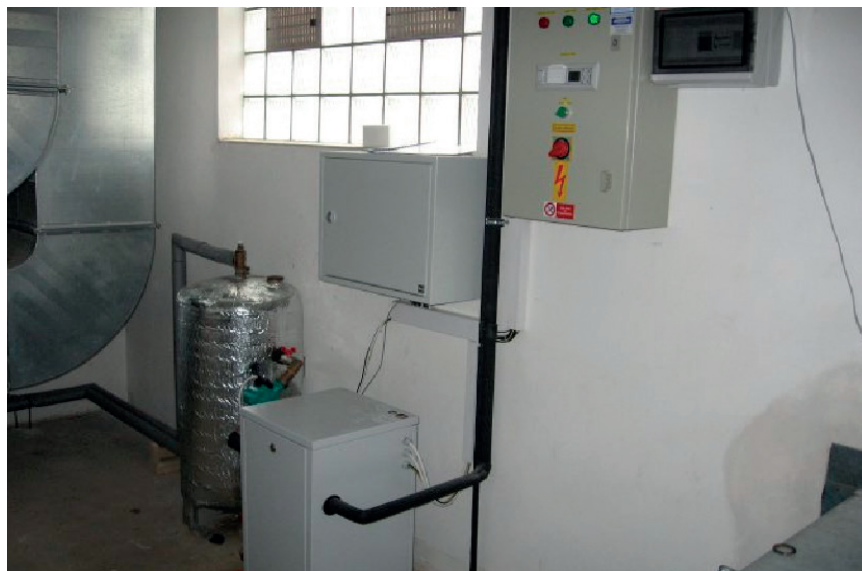
Obr. 30. Malé tepelné čerpadlo a zásobník vody v experimentálním recirkulačním systému.
