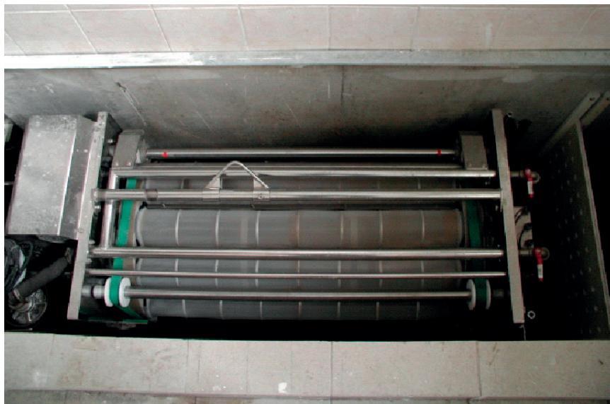
Obr. 8. Otevřený bubnový mechanický filtr IN-EKO. Foto P. Kozák.
