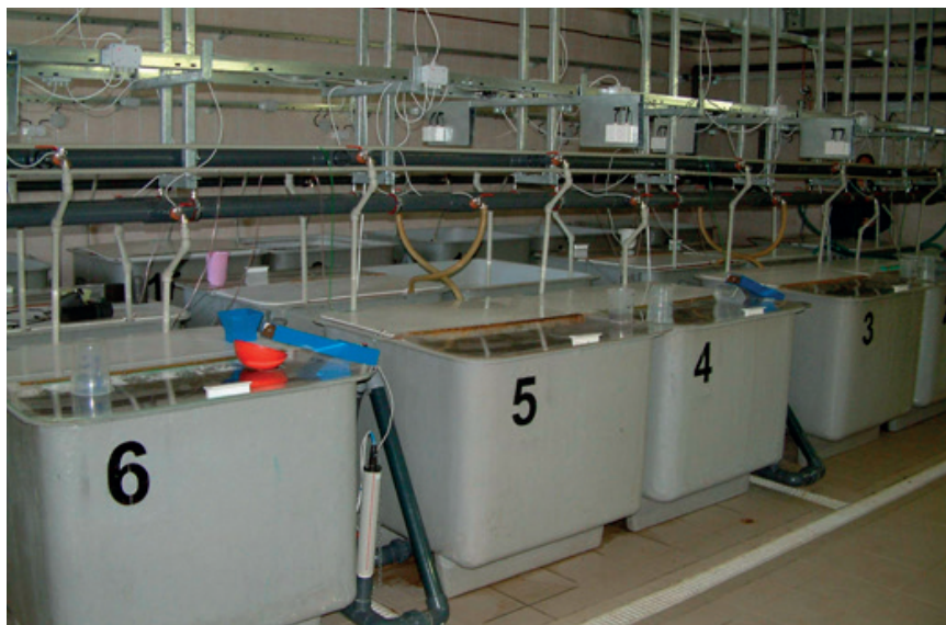
Obr. 32. Interiér experimentálního recirkulačního systému (na odtoku z levé nádrže je zabudovaná měřící sonda na kyslík). Foto J. Kouřil.
