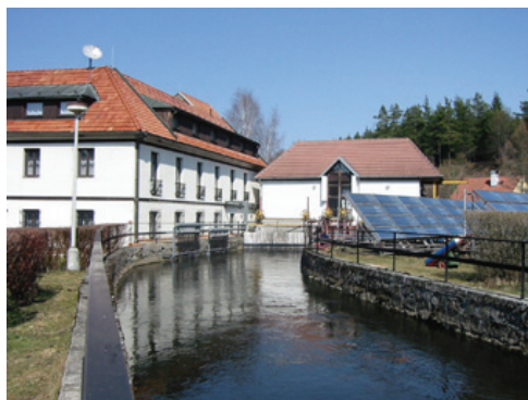
Obr. 16. Pohled na mlýnský náhon a sluneční kolektory.
