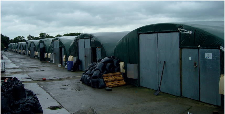
Obr. 4. Lehké stavby (dvě vrstvy folie, jedna vrstva izolační minerální vlny) sloužící pro intenzivní chov okouna říčního v Irsku (Clune Fisheries Ltd.).
