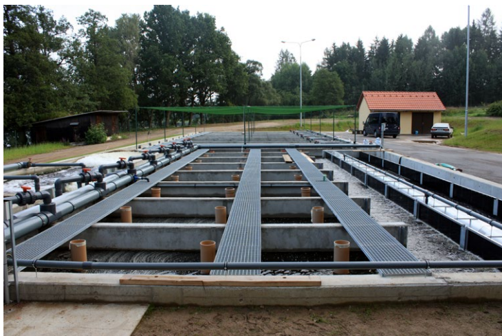
Obr. 10b. Již provozovaný systém převážně pro odchov pstruha duhového (BioFish s.r.o. Sádky Pravíkov, foto R. Kopp).
