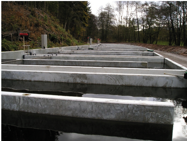
Obr. 10a. Nově budovaný intenzivní RAS dánského typu (Fischzucht Rhönforelle GmbH & Co. KG, Německo, foto D. Gela).
