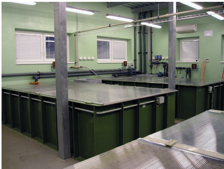
Obr. 6. Zakrytí odchovných nádrží komůrkovým polykarbonátem proti vyskočení ryb z bazénu a snížení vlhkosti vzduchu v hale výparem vody z hladiny (FROV JU, Vodňany, foto D. Gela).
