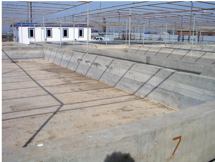
Obr. 8c. Venkovní vypuštěné nádrže s vybetonovaným dnem pro intenzivní odchov rozkrmeného plůdku jeseterů (Astrachaň, Rusko, foto J. Kouřil).
