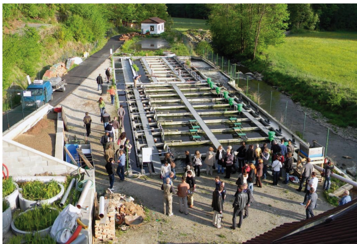
Obr. 10d. Recirkulační systém dánského typu používaný pro odchov lososovitých ryb a jesetera (Josef Bláhovec, Pstruhařství Mlýny, foto M. Aldorf).
