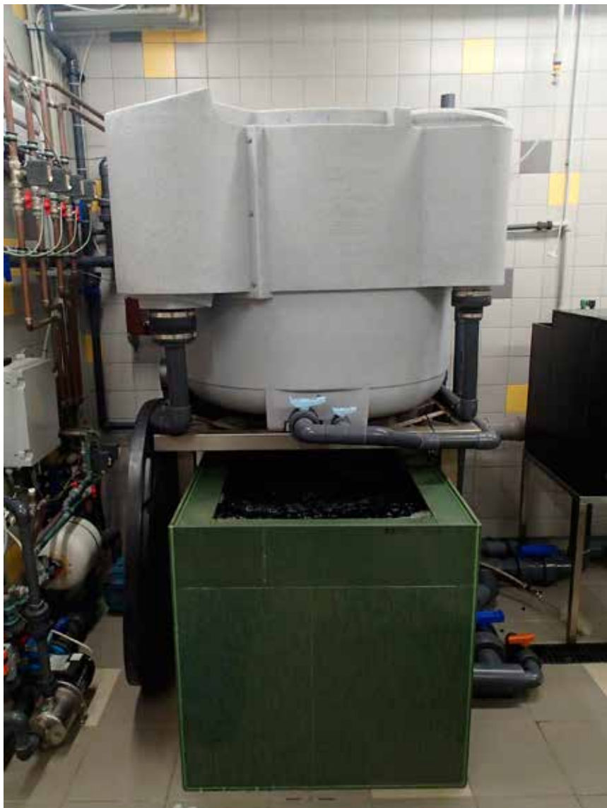
Obr. 7. Biologická filtrace, která byla tvořena předfiltrem Nexus 310 a airliftovým biologickým filtrem vlastní konstrukce (FROV JU), využívaná v RAS během realizace poloumělých výtěrů candáta obecného ( Sander lucioperca L. ) (foto T. Polícar).
