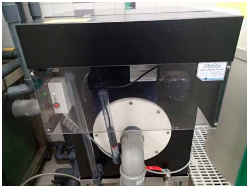
Obr. 6. Detail mechanického bubnového filtru BaseDrum 15/60 od německé firmy Ratz Ltd. využívaného v RAS v rámci realizovaných poloumělých výtěrů candáta obecného ( Sander lucioperca L. ) (foto T. Polícar).
