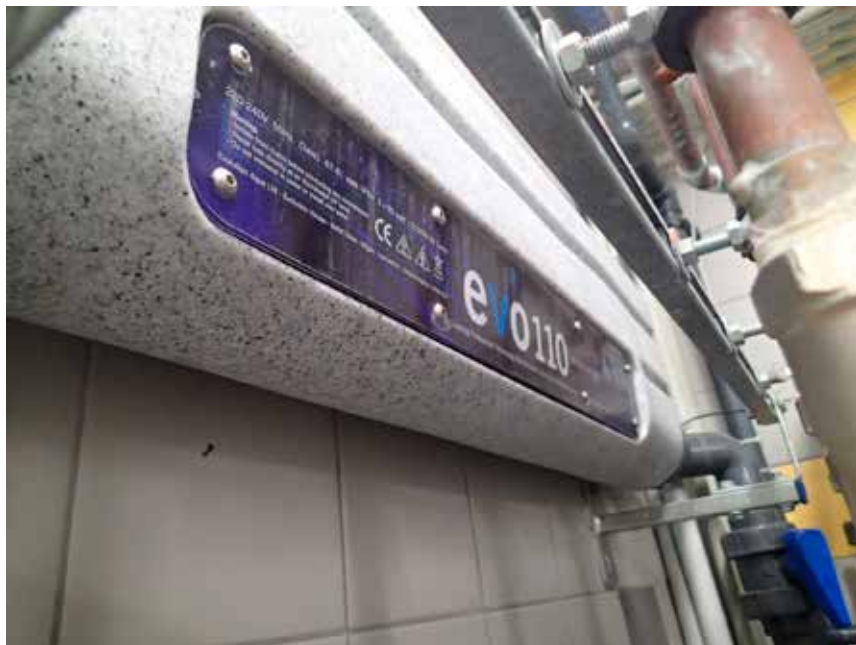
Obr. 8. UV zářič EVO 110 využívaný v RAS během realizace poloumělých výtěrů candáta obecného ( Sander lucioperca L.) (foto T. Polícar).
