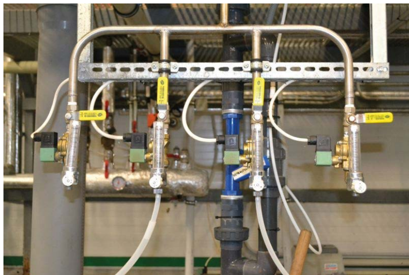
Obr. 12. Plovákové průtokoměry kyslíku s redukčním ventilem, které regulují průtok kyslíku směšovačem (Foto: J. Hampf).
