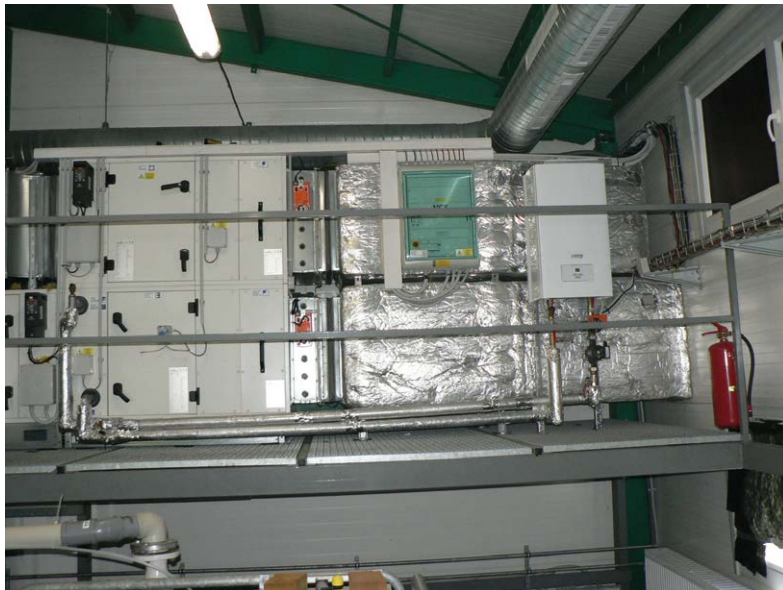
Obr. 17. Klimatizace s elektrickým kotlem, který je využíván k udržování nízké vzdušné vlhkosti a optimální teplotě vzduchu v experimentální rybochovné hale (Foto: T. Polícar).
