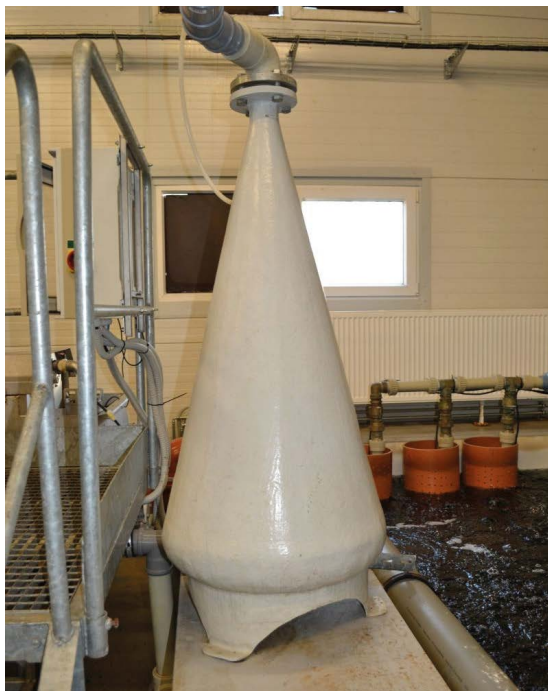
Obr. 11. Směšovač vody s kyslíkem využívaný v každé RAS (Foto: J. Hampl).
