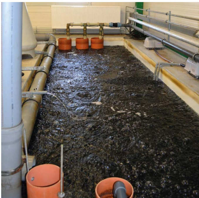
Obr. 6. Biologický filtr s pohyblivým ložem (Foto: J. Hampf).
