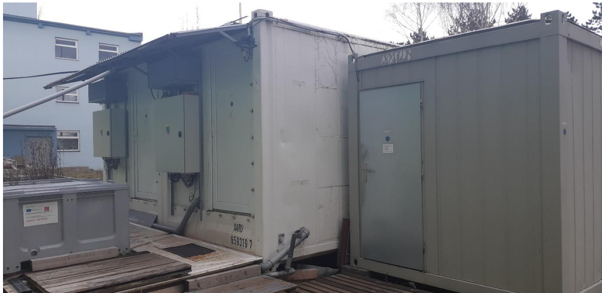
Obr. 7. Investičně úsporný chovný systém modulární konstrukce – kontejnerová farma (zleva kontejner K2, uprostřed kontejner K1 a technické zázemí farmy vpravo).
